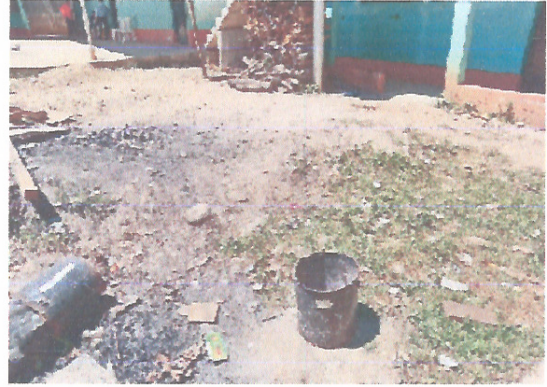
Foto 2: MANTENIMIENTO DE LOSA DE PATIO
