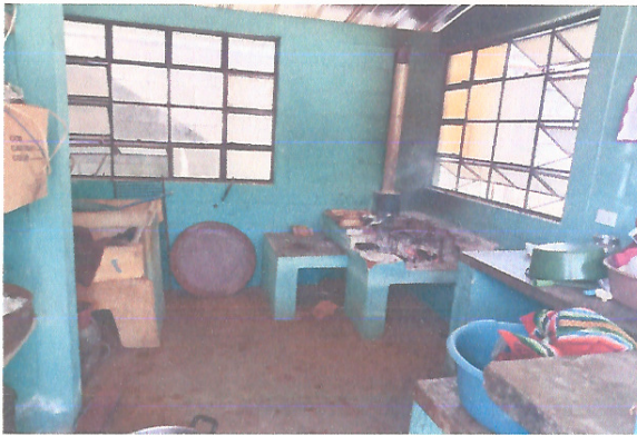
Foto 3: MANTENIMIENTO DE REPARACIÓN O SUSTITUCIÓN DE AREA DE COCINA (ESTUFAS RURALES, PILAS, VENTANAS, PUERTAS, CHIMENEAS, OTROS)
