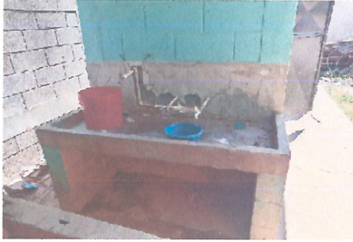
Foto 1: MANTENIMIENTO DE REPARACIÓN RED DE DRENAJES Y RED DE AGUA POTABLE
